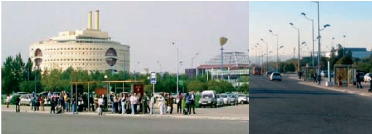
Arriba, parada de Chapina antes de la reordenación ( la izquierda) y las tres nuevas marquesinas instaladas. A la derecha, bahía junto a Hiperpor en San Juan de Aznalfarache
